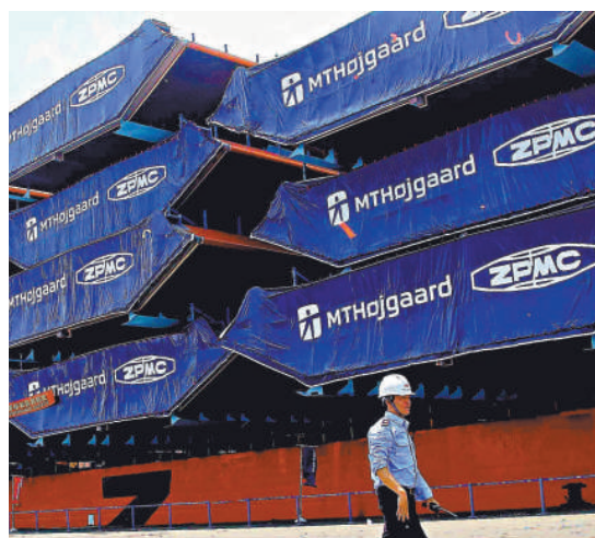
▲由上海振華重工承建的挪威哈登角鋼橋主體鋼結構一日在上海啓運挪威 新華社
