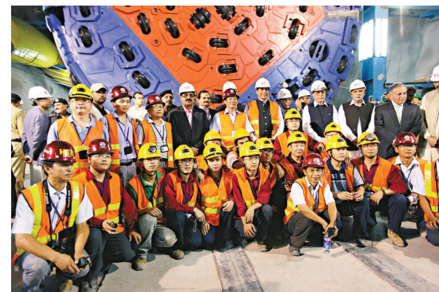
▲在巴基斯坦尼魯姆一杰盧姆水電工程位於巴控克什米爾的項目施工現場，巴基斯坦總理阿什拉夫（後排着橙色背心）等六日出硬岩掘進機主機啓動儀式 新華社
