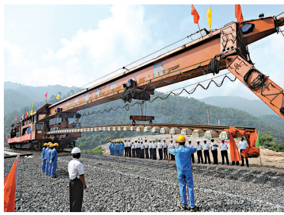
▲14日，施工人員在鋪設雲南玉（溪）蒙（自）鐵路最後一節長鋼軌
