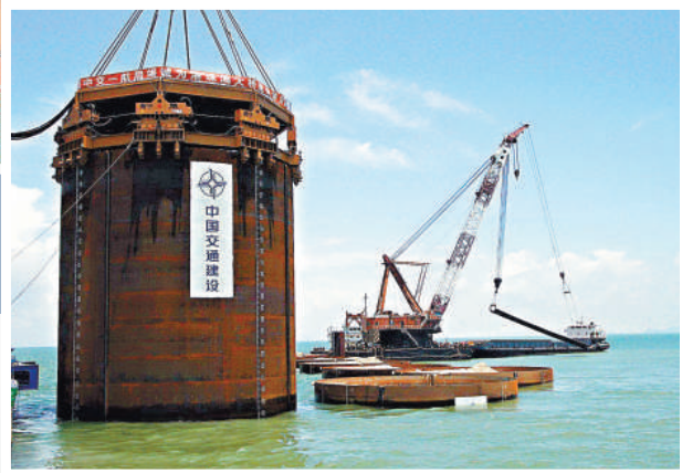
港珠澳大橋由鋼筒圍築而成的西人工島全景
