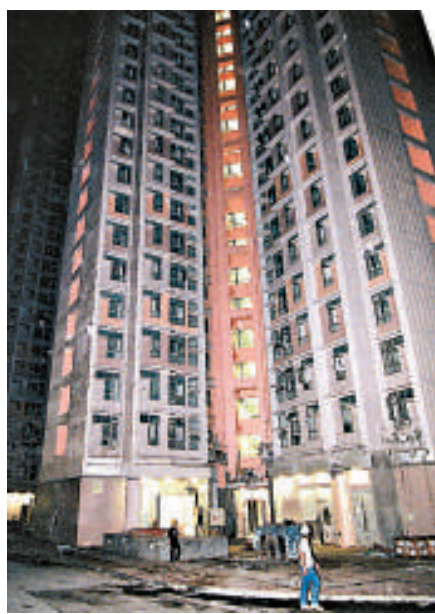
▶天頌苑被揭發短樁後，由房委會斥巨資進行修復工程
