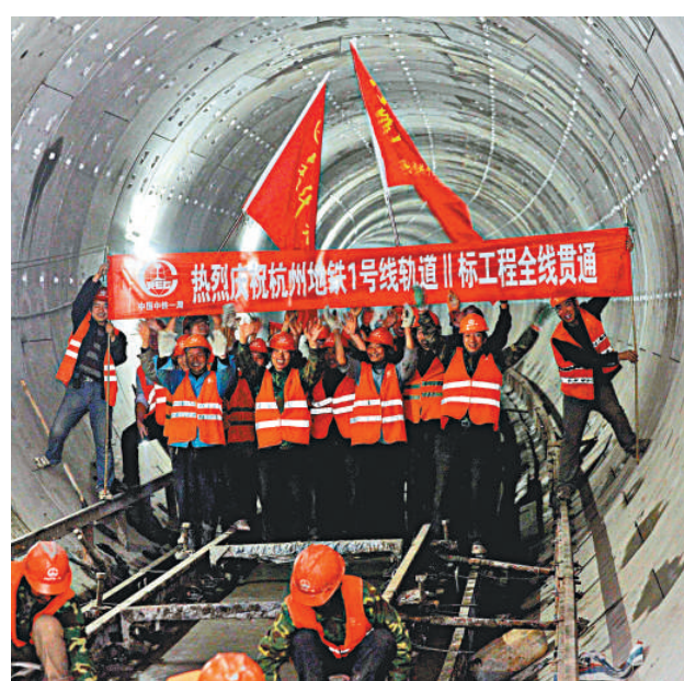
▲今年4月10日，杭州地鐵一號線軌道二標段順利實現軌通
