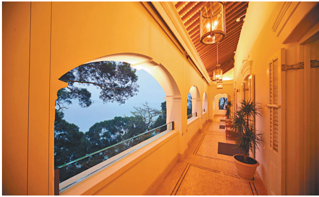
◀大澳文物酒店的走廊，拱形大窗的圍欄高度不夠一點一米，須加裝玻璃，但玻璃底部不能碰到下面的原裝麻石，安裝難度較高 廖宜康提供圖片
