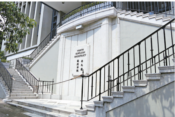
◀北九龍裁判司署出入口正門大梯，因為欄杆下的空隙太闊，活化後變成不符合建築物條例規定，平時不開放予公眾使用
