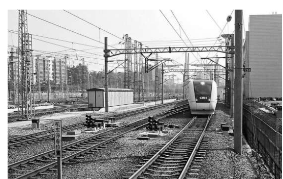
▲穗莞深城軌將通過改造廣深鐵路四線，連通廣州東站，實現與廣深鐵路無縫銜接
