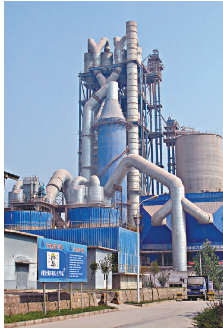
▲西部水泥收購的渭南寶豐廠房
