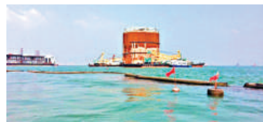
▲大直徑鋼筒深入海底，快速形成人工島
