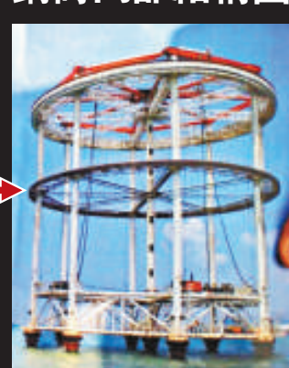
●鋼筒直徑達31米，圓形工作台位於鋼筒內，直徑相若，方便工人施工，配有八部起重機件，可在鋼筒內升降
