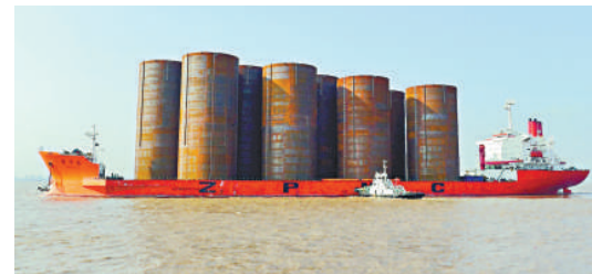
▲「人工島圍護鋼筒」由大型貨船運抵施工海域
