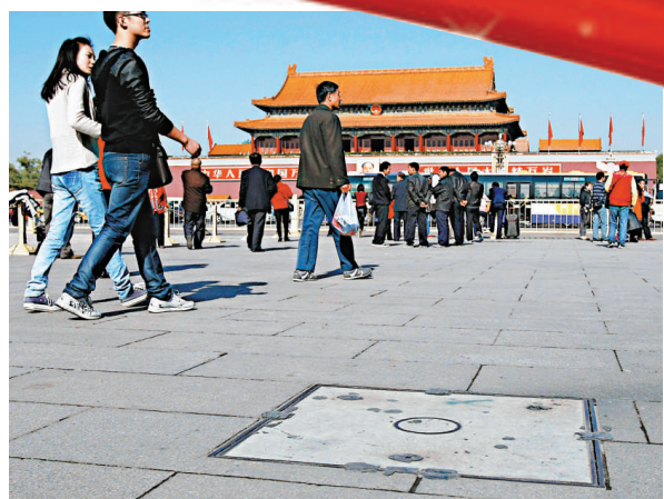
▲北京市將天安門地區所有井蓋更換成防響、防跳、防盜、防墜落、防位移「五防」井蓋 中新社
