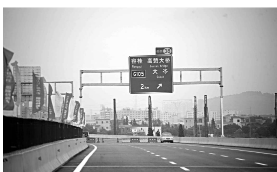
▲廣珠西線三期正進行路面鋪設及交通設施調試，預計明年2月全線貫通 本報記者方俊明攝
