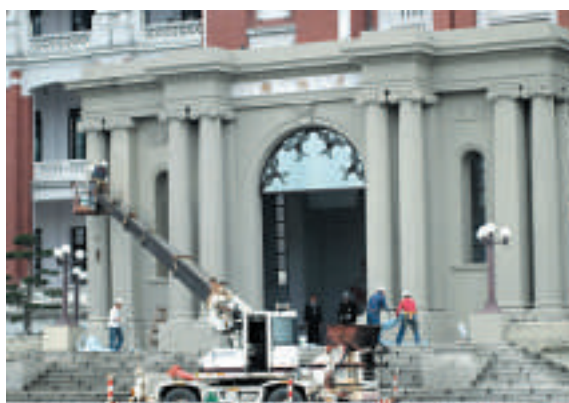
▲島內工程人員26日修復「總統府」正門 法新社
