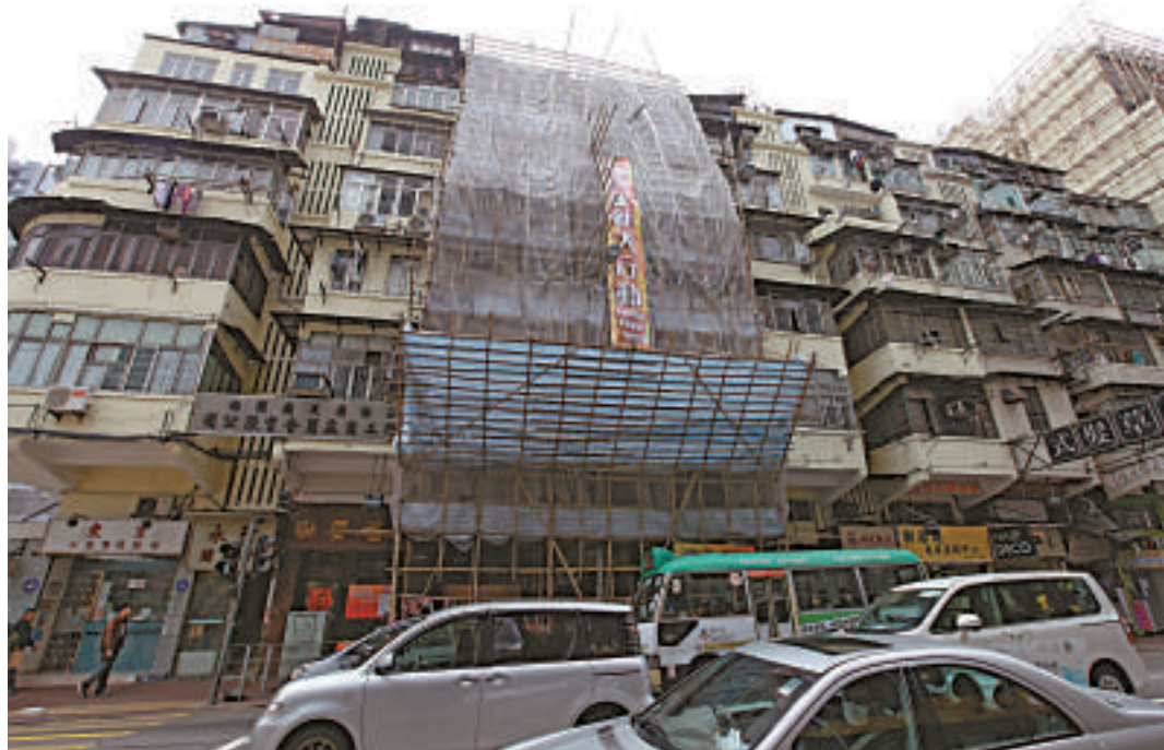
部分樓宇參加了樓宇更新大行動，樓宇外牆已搭起棚架與圍網，準備進行維修工程
