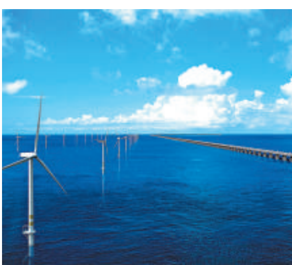
▲中電新能源東海大橋項目
