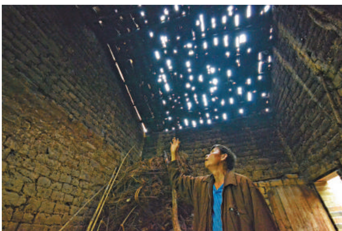
▲3月30日，廣西岑溪市南渡鎮古太村一位村民家的雜物房屋頂被冰雹打壞
