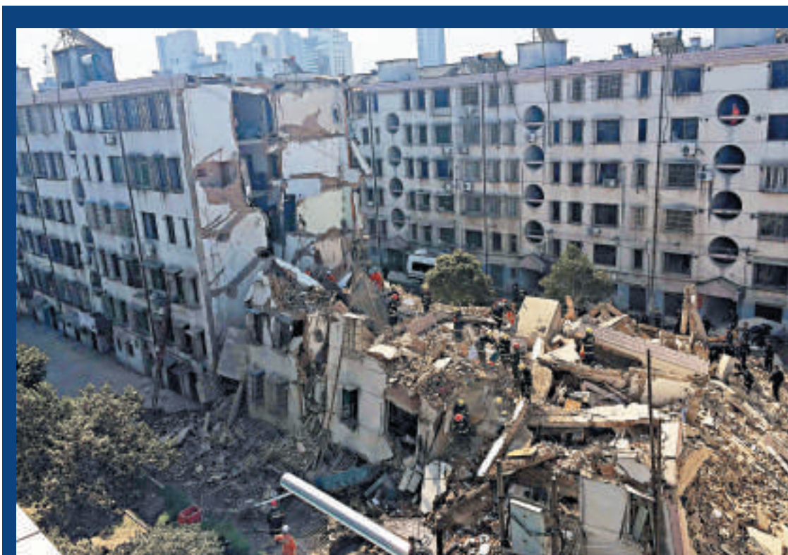
▲與倒塌的29幢同社區的其他樓，以及許多同街道的其他社區樓房也都存在安全隱患。圖為事故現場
