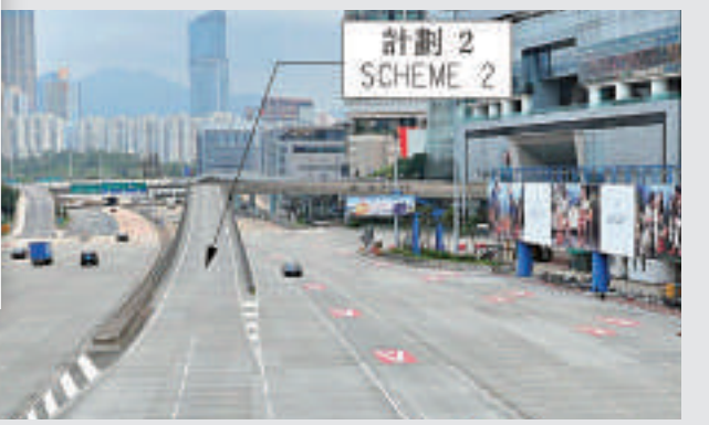
▼計劃2是興建一條高架單線行車道，連接雅翔道高架路段至西區海底隧道收費廣場 運房局模擬圖
