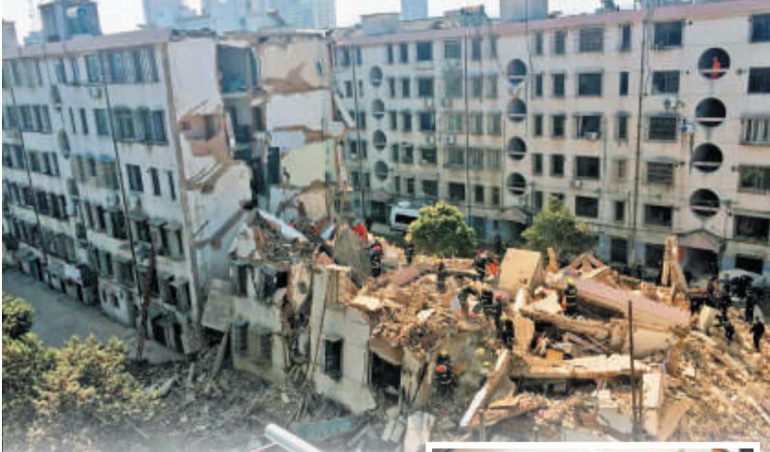
▲4日發生在浙江奉化的塌樓事故導致1死6傷 新華社
