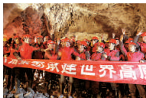
▲15日，青藏鐵路新關角隧道全線貫通，隧道兩頭的工人聚合慶祝 中新社
