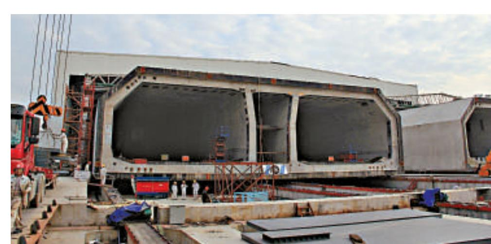
港珠澳大橋海底隧道沉管已安裝至第10節，是總節數的1/3，圖為管節頂推施工
