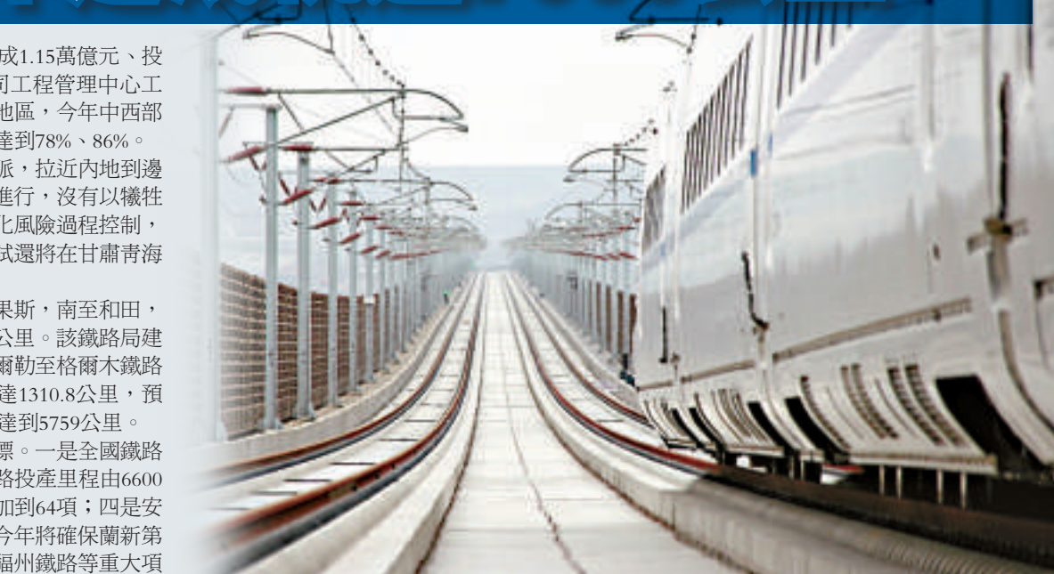
▲蘭新高鐵路全線長1776公里。圖中路基兩側為採用耐候鋼板的橋樑擋風屏
