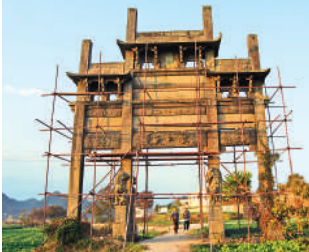
▼屯溪區南溪南村修繕吳中明坊 柏永攝
