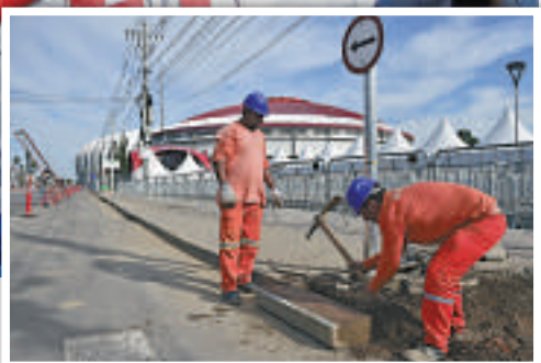
▲世杯另一比賽場地阿雷格里港的貝拉一里奧球場外施工尚未完成 法新社
