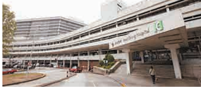
▼葵涌醫院重建工程將分三期進行 資料圖片
