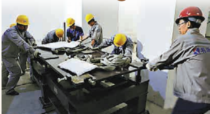
▲工人在武威重離子治療腫瘤中心安裝重離子加速器部件 網絡圖片
