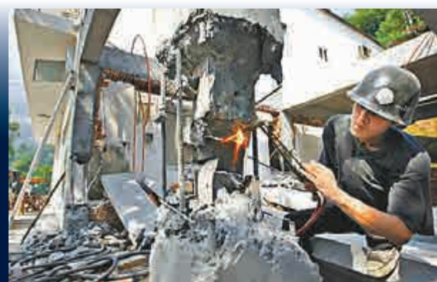
◀溫州市龍灣區礪溪鎮，一名工人在拆除違章建築
