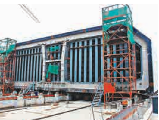
▲港珠澳大橋沉管隧道建設突破2000米，挺進隧道最深處，圖為大橋沉管管節安裝作業 本報記者方俊明攝
