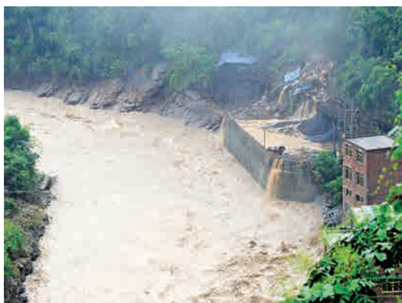
▲1日，重慶雲陽縣事發煤礦的部分建築被泥石流衝垮
