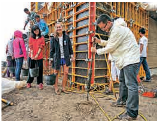
▲穆鈞在示範操作電動夯土機器
