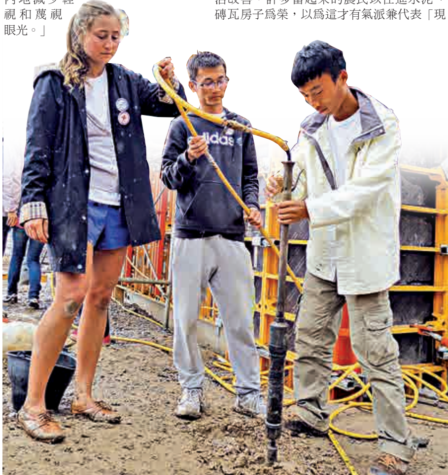
▲穆鈞的助手、李強強在操作夯土機 ▶無止橋義工們與鍾逸傑等大合影
