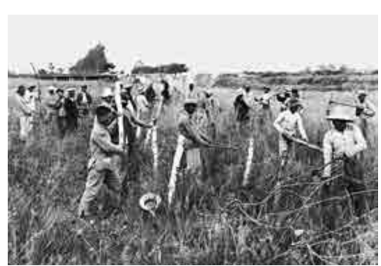
▲拆卸鐵絲網的中國工人
