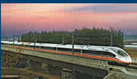
▲中國中鐵參建的世界首條高寒地區高速鐵路——哈大客運專線
