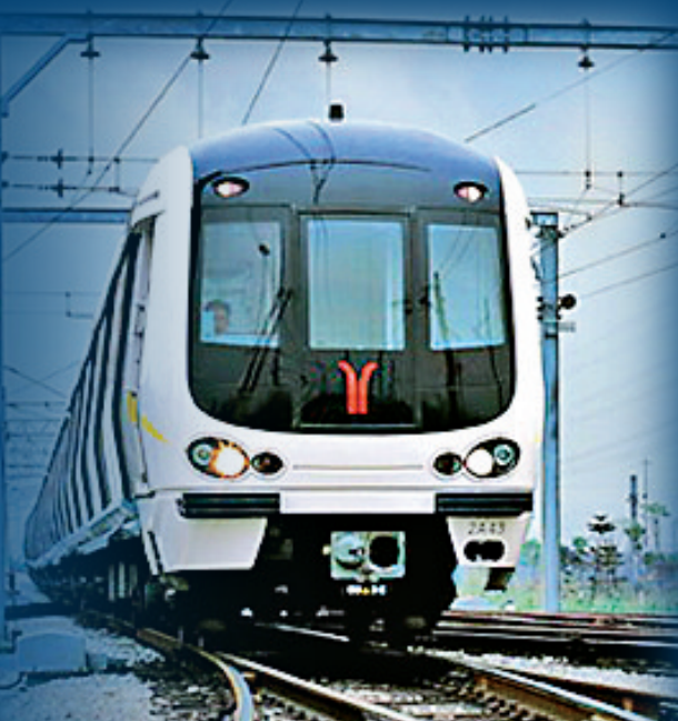
▲中鐵電氣化局集團有限公司城鐵公司建設的地鐵
