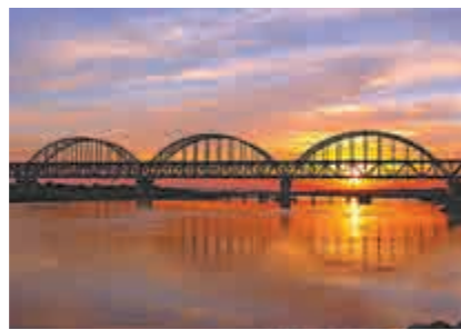
▲中國中鐵承建的京滬高速公路黃河大橋
