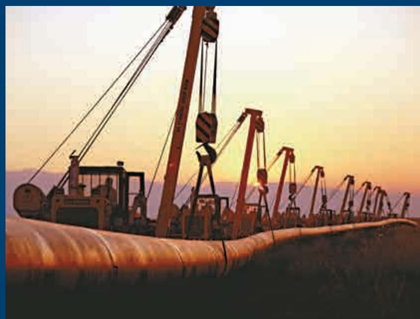
▲中亞天然氣管道在進行整體吊裝轉運
