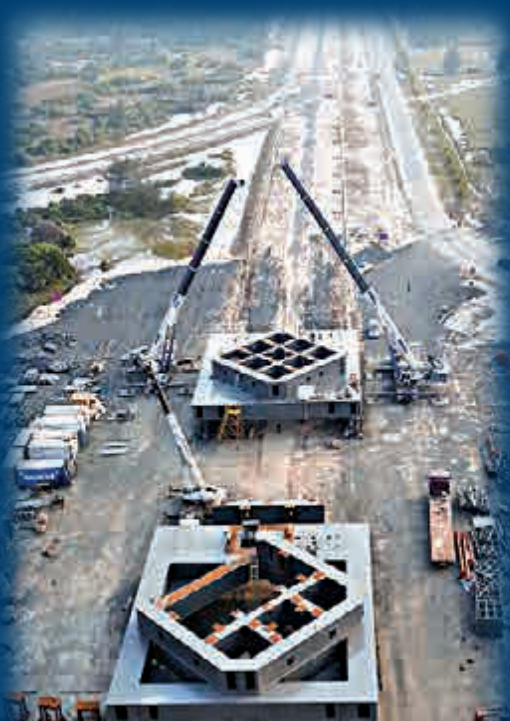
▲長五、長七發射平台主體結構安裝完成
