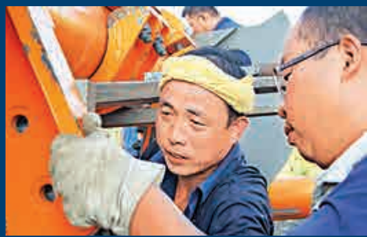
▲工人冒着高溫在海南發射場安裝調試長五、長七活動發射平台
