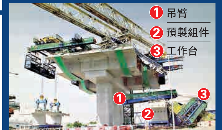
▲出事起重機吊臂連工作台倒塌,等候吊運預製組件遺留地面 周聯橋提供
