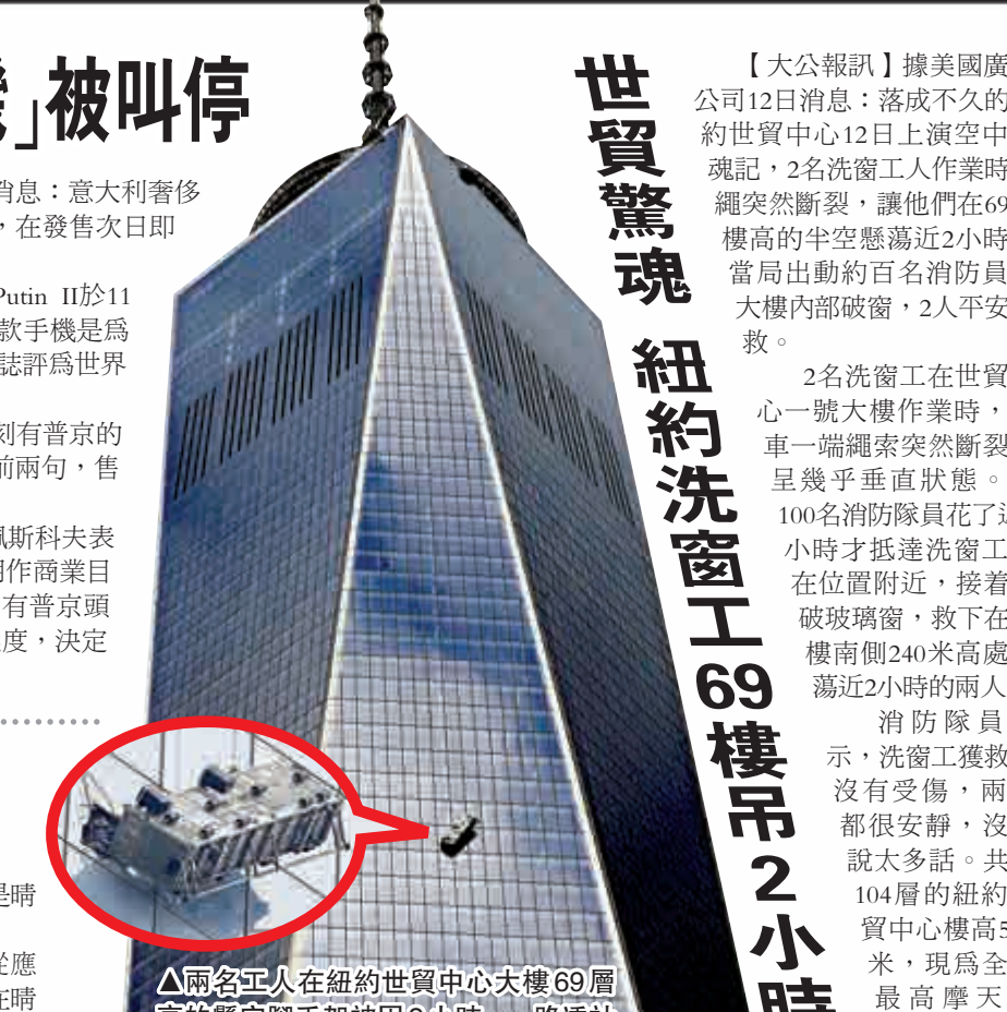
△兩名工人在紐約世貿中心大樓69層高的懸空腳手架被困2小時。路透社
