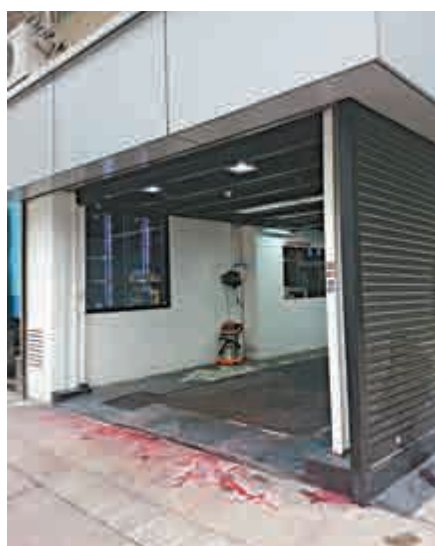
▲洗車屋大門兩邊鐵閘遭潑紅色漆油
