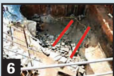
6 石砌路徑及前馬頭涌河岸結構 (石砌路徑：宋元；石結構：晚清至民國) 位置：行人通道北端 建議：原址保留
