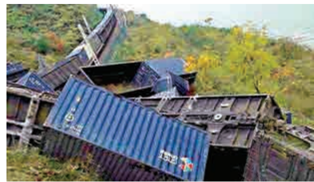
▲24日，襄渝鐵路陝西旬陽段15時許發生山體塌方，導致一列貨運火車8節車廂脫軌，駕駛員遇難
