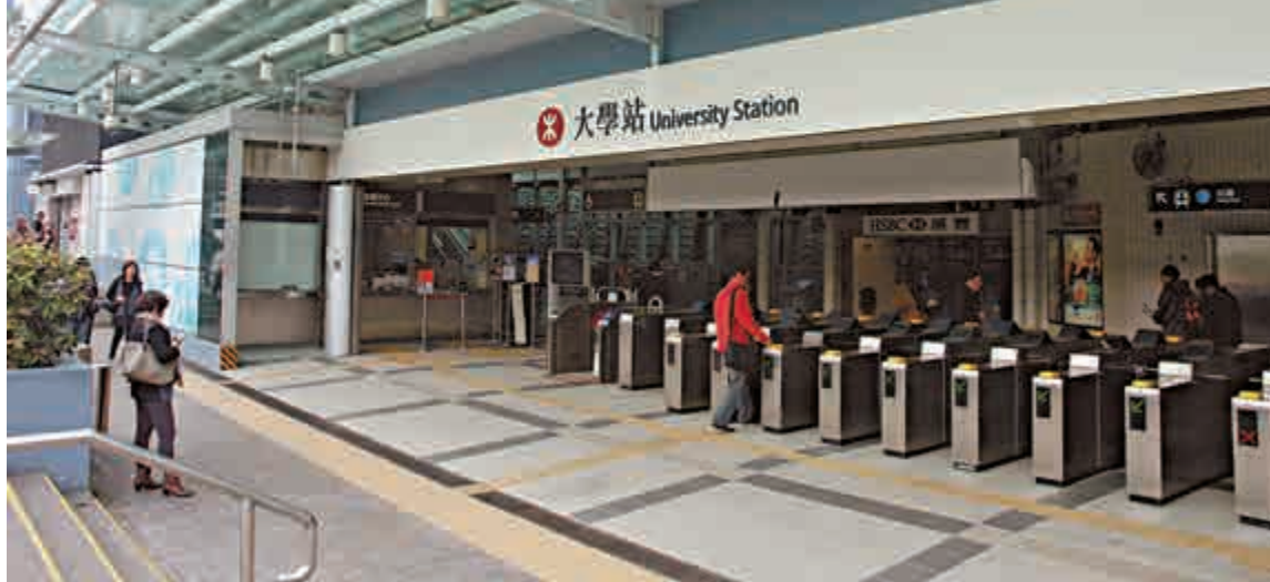
發生電纜故障的港鐵大學站
