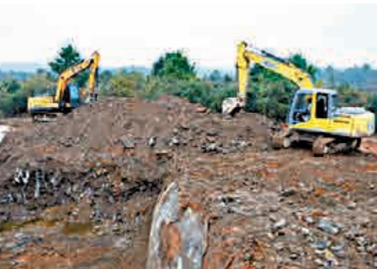
▲12月11日，桃源縣架橋鎮白馬崗山頂上，晟通集團常德產業園的施工人員在挖掘埋藏的含氟固體廢料
