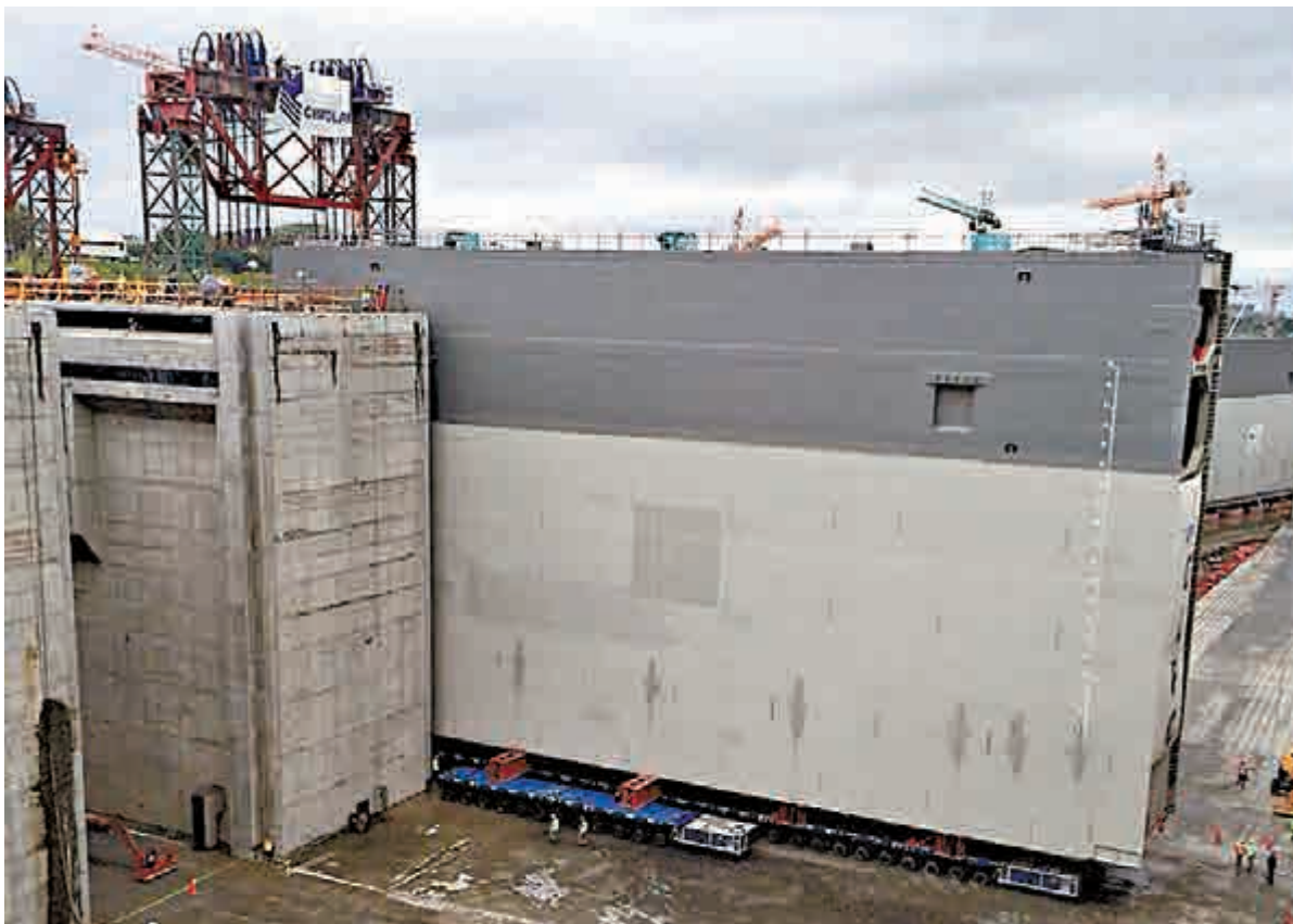
▲運河聯合集團提供的正在擴建中的巴拿馬運河第一道閘口 法新社
