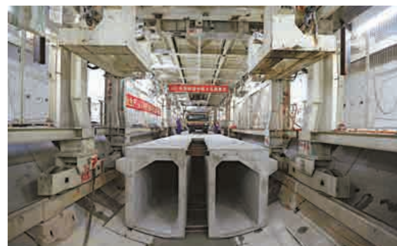
▲廣深港高鐵路益田路隧道29日全線貫通 新華社
