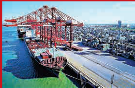
▲建設中的南沙港區 網絡圖片
