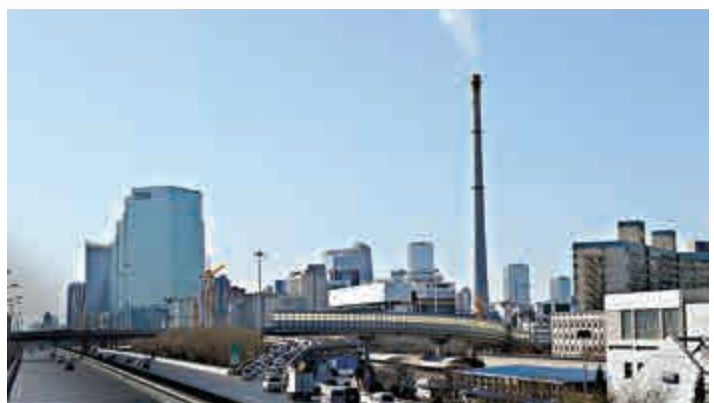
▲國華北京熱電廠燃機組20日關停 網絡圖片
