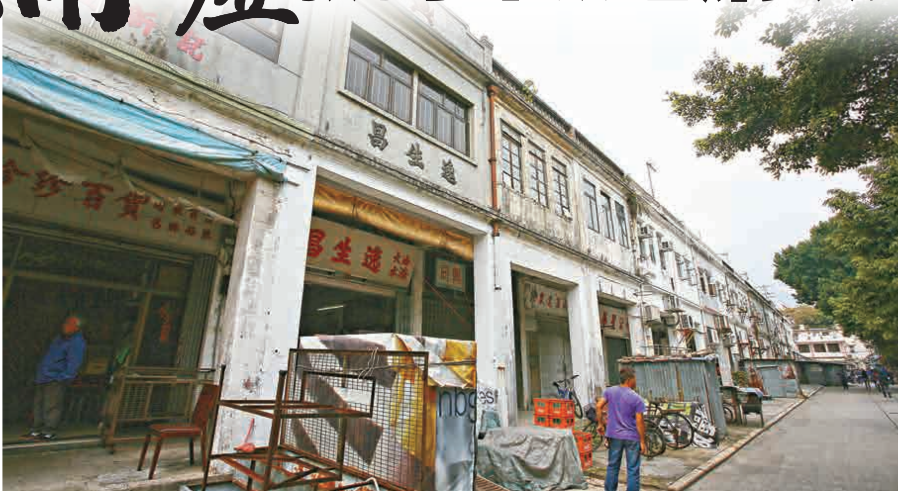
▲沙頭角墟禁區內包括新樓街一列數十舖位，合共有約150間現成的商舖可接待遊客
