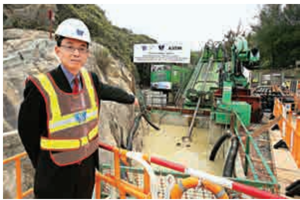
▲梁中立昨表示，「水平定向鑽挖法」毋須挖掘海床，有助減少影響海洋生態。本報記者麥潤田攝
