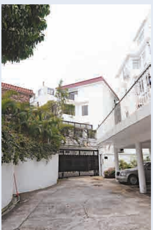
▲白建時道59號外貌
