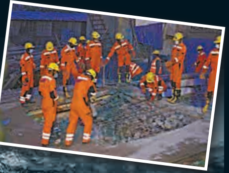
中國、印度、丹麥和尼泊爾救援力量28日在加德滿都合力挖掘一處倒塌的六層大樓 新華社
