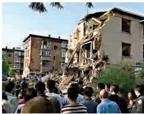
▲爆炸致一側樓體倒塌 網絡圖片
